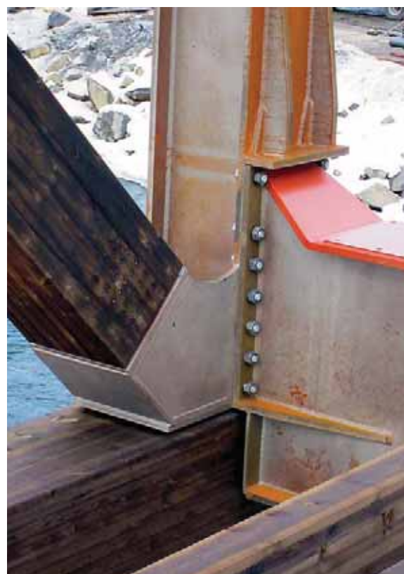
Opphenging av fagverk på tverrbærere over pilar.
