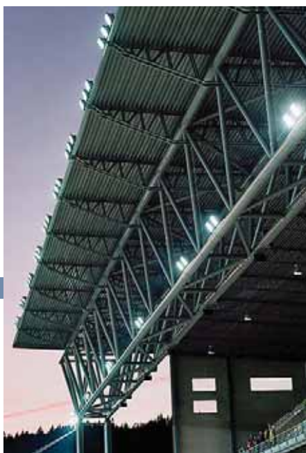
Fackverksbalken på Borås Arena – EABs största utmaning hittills.
