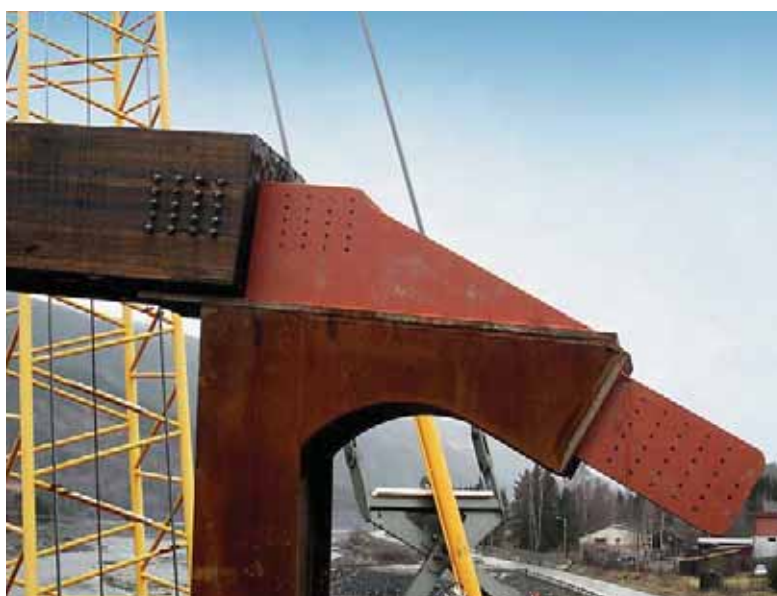
Opphenging av fagverk på tverrbærere over pilar.
