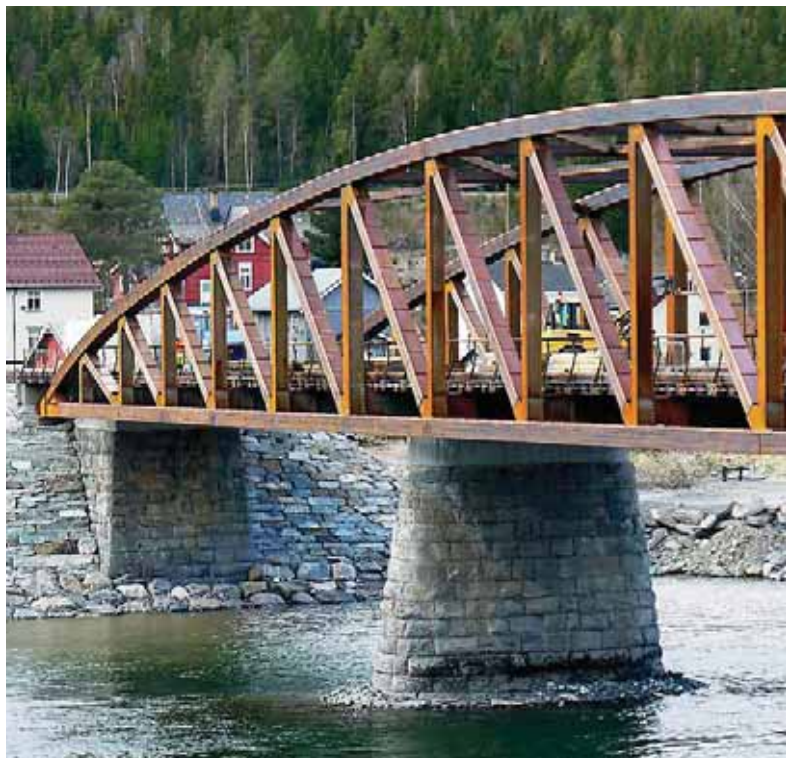
Eksisterende fundamenter i vest.
