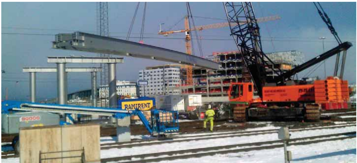
Montering av bro for NSB ifm tverrforbindelsen i Trondheim.
