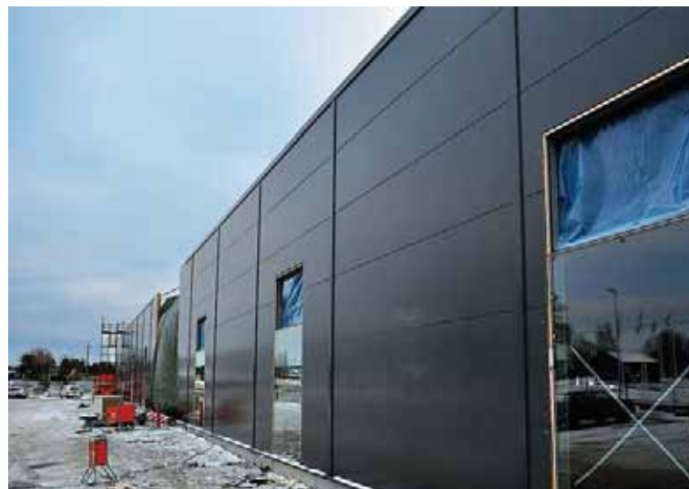
Fasaden mot Iseveien, kledd med Ruukki Life Panel.
