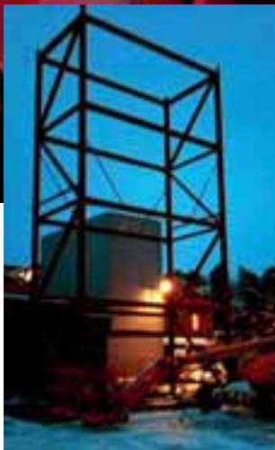
Höglagret i Täby innan vägg-elementen är monterade.
